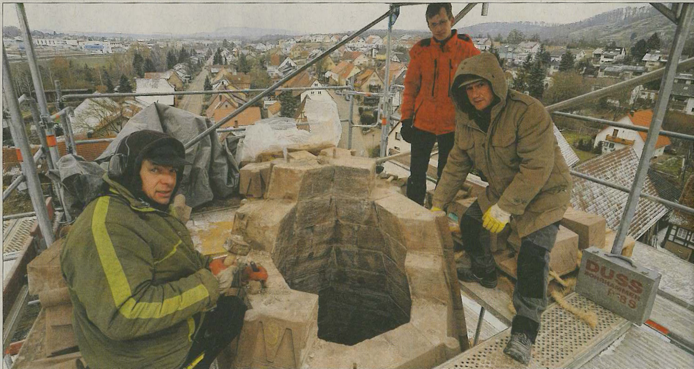
Über den Dächern von Schönenberg: Die Steinmetze Frank Sommerfeld (li.) und Josef Reisenhauer (re.) von der Firma Holz aus Eppingen erneuern den Sandstein-Aufbau an der Kirchturmspitze. Als schwindelfreier Beobachter verfolgt Pfarrer Markus Epting die Arbeiten. Fotos: Fotomoment
